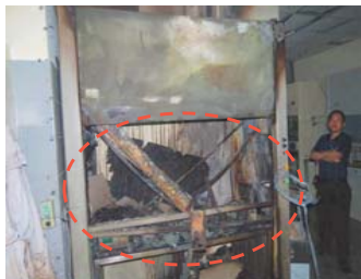
事故之化學處理排煙櫃
