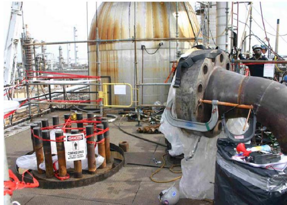
圖 1-11 為完全關緊閥而使用的盲板
