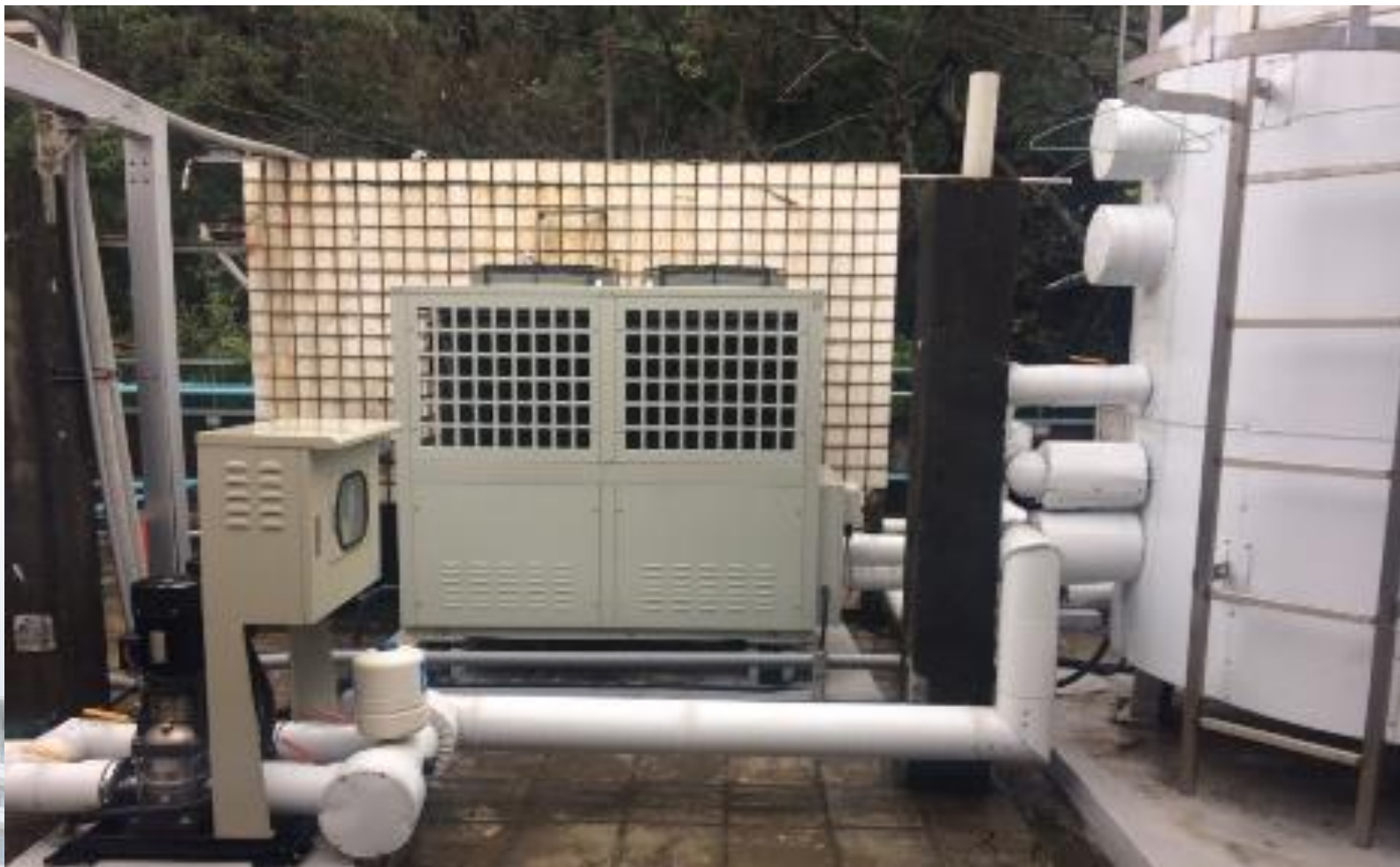
學生宿舍熱泵加熱系統
